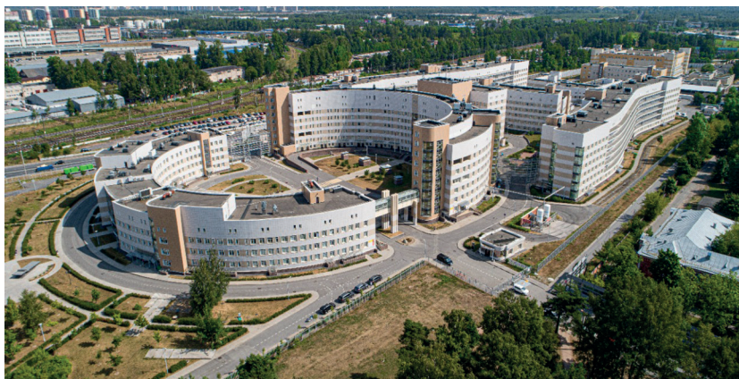
Новая площадка Больницы Боткина на Пискаревском пр., д. 49
