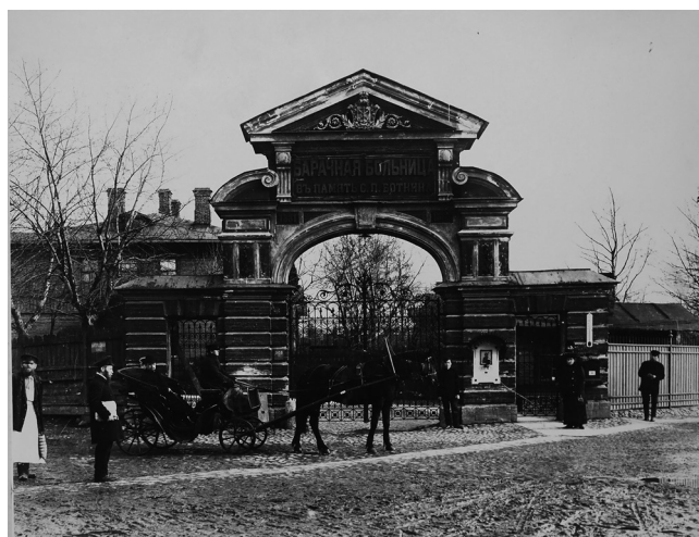
Центральный въезд в больницу
