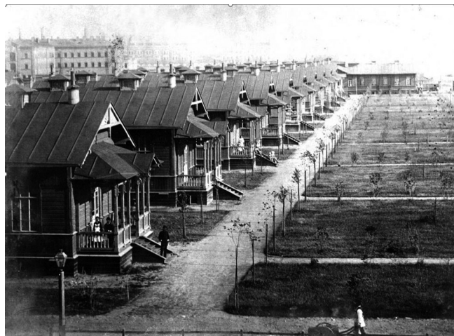
Одноэтажные деревянные бараки, построенные в русском классическом стиле, располагались симметрично в два ряда вдоль Кременчугской улицы (инженер-архитектор Соколов Д.Д.)
